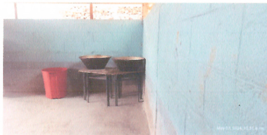
Foto 2: Mejoramiento modulo de cocina.
