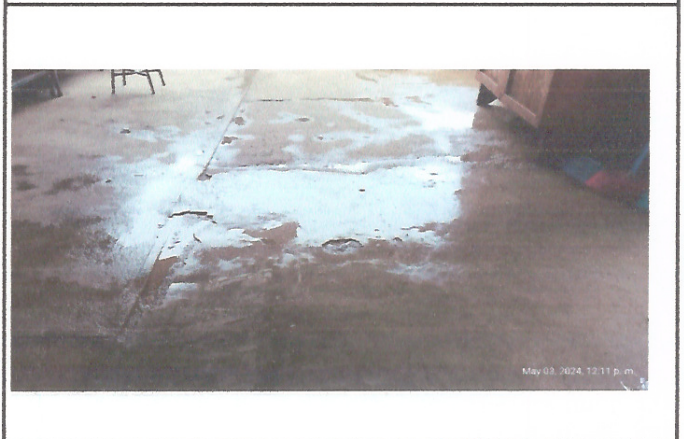
Foto 4: Mejoramiento de piso (Ceramico de alto impacto)
