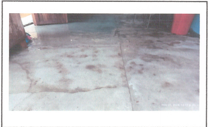
Foto 2: Mejoramiento de piso (Ceramico de alto impacto)
