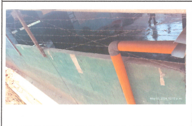
Foto 3: Mejoramiento modulo de corredor.
