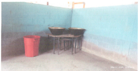
Foto 3: Mejoramiento modulo de cocina.
