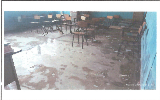
Foto 1: Mejoramiento de piso (Ceramico de alto impacto)
