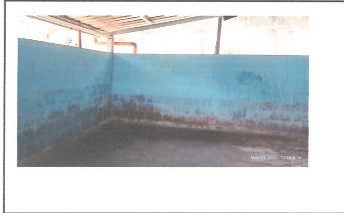
Foto 1: Mejoramiento modulo de corredor.
