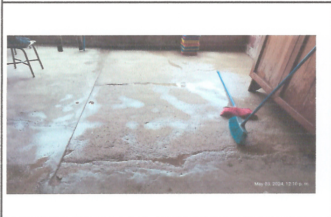
Foto 3: Mejoramiento de piso (Ceramico de alto impacto)
