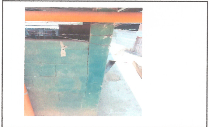
Foto 2: Mejoramiento modulo de corredor.
